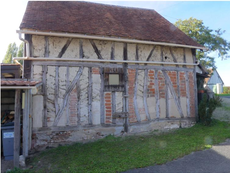
Comme vous le voyez, le remplissage d'origine est très abîmé, il a été remplacé au fil des années par diverses briques, le soubassement est à ré-endoquer... Nous avons donc plusieurs journées programmées pour démonter avec soin le remplissage actuel, retailer des « rollons » et les mettre en place, préparer le mélange terre/végétal, le poser sur les rollons et appliquer la couche de terre qui recevra après séchage l'enduit chaux...
